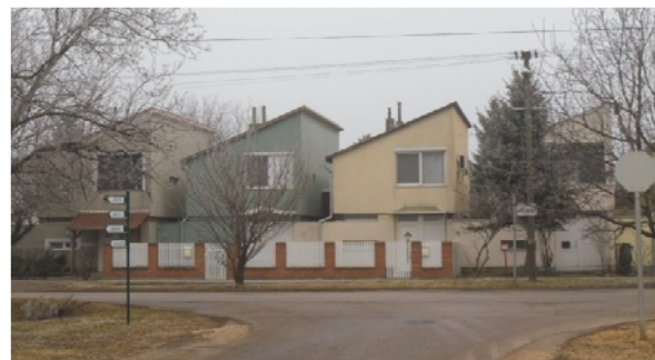
Sorház jellegű beépítés a Fő út mentén Kápolnásnyéken
